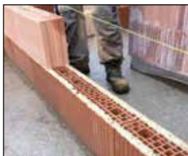
De ThermoPlan® blokken zijn zeer vlak. Na een goede start – een perfecte kimlaag – kan men zeer snel werken.
