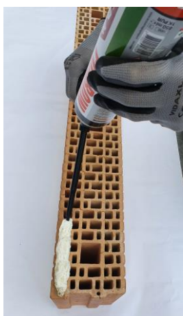
4. Appliquer les cordons de colle sur des blocs propres et dépoussiérés. (2 cordons horizontaux par briques en suivant les rangées d'alvéoles jouxtant les parois extérieurs)
