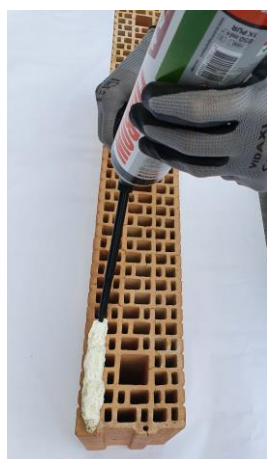
4. Appliquer les cordons de colle (2 cordons horizontaux par briques en suivant les rangées d'alvéoles jouxtant les parois extérieures)
