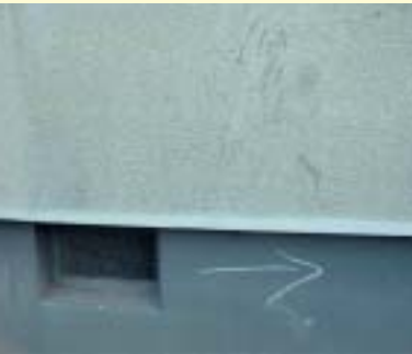
Wärmebrücke Sockelschiene
