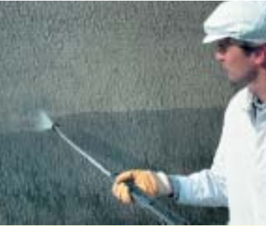
Reinigen einer befallenen Fassade
