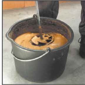
Der Dünnbettmörtel wird mit Wasser und dem Quirl angerührt und dann zur Verarbeitung in eine Mörtelwanne gefüllt.
