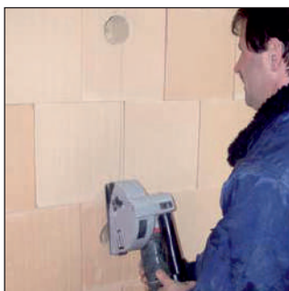
Schlitzten der Ziegel mit der Schlitzfräse.
