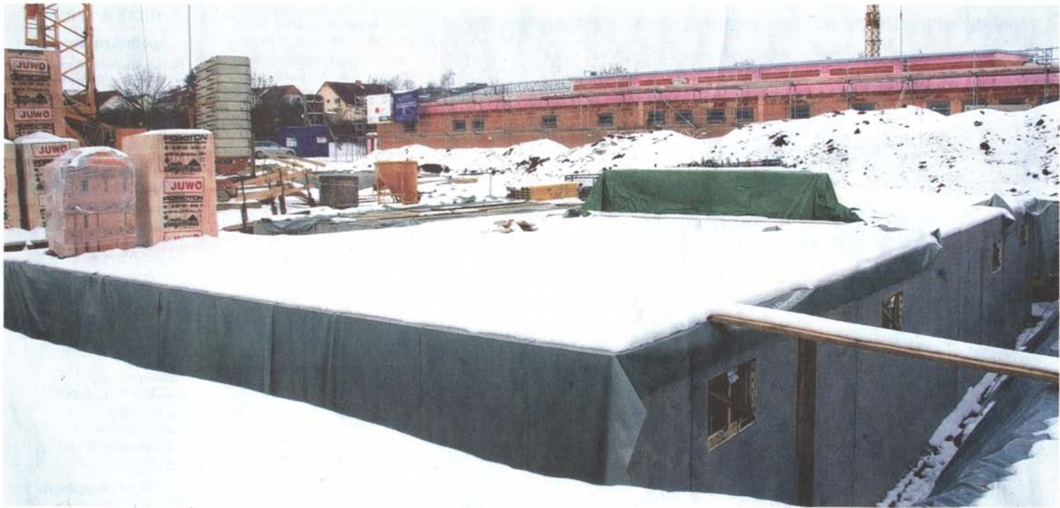
Am Büttengeweg beim Feuerwehrhaus lässt die Gewobau zurzeit zehn Wohneinheiten errichten.
